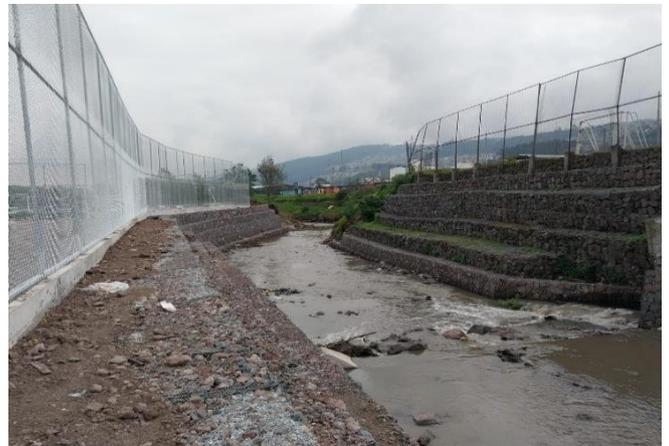
✓ MUROS DE ESTABILIZACIÓN, CONTENCIÓN, REVESTIMIENTO
