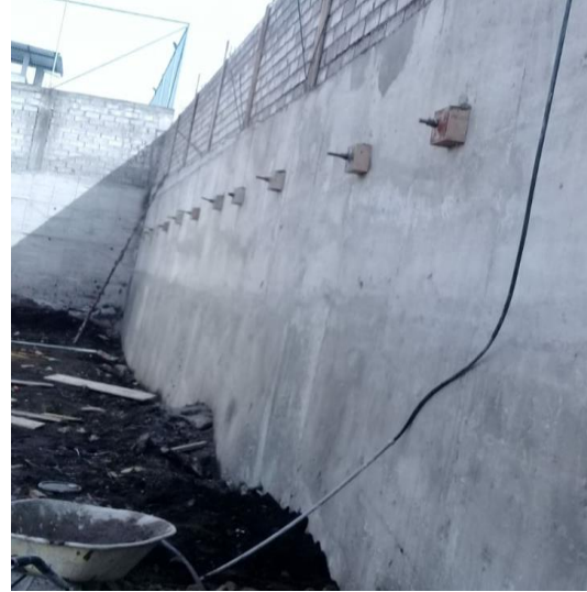
Obra en ejecución
