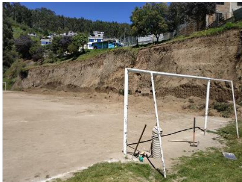
Inicio de Obra
