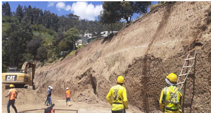
Obra en ejecución
