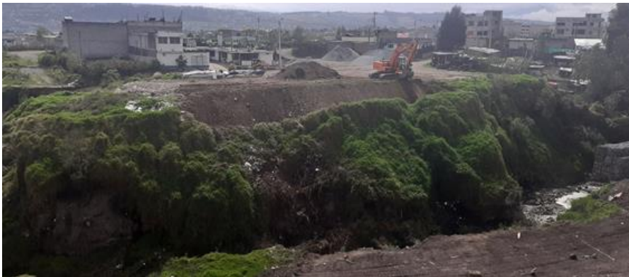
Obra en ejecución
