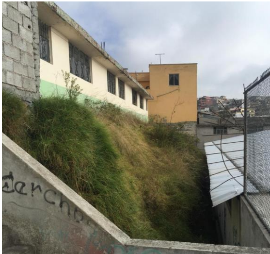
Inicio de Obra
