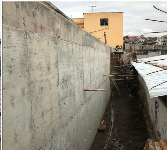
Obra en ejecución
