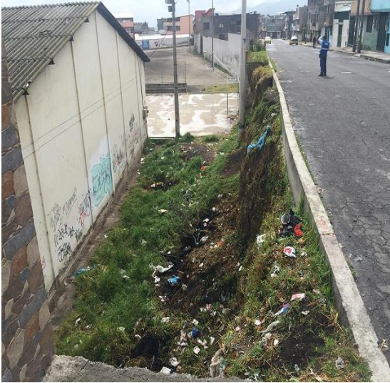
Inicio de Obra
